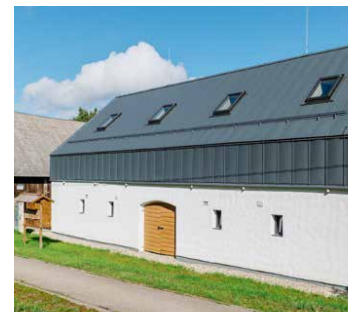
Kā atsauce uz ēkas vēsturisko izskatu ir restaurētas un vecajā vietā atliktas milzīgās arkveida koka durvis ielas fasādē – tagad tās kalpo vairs tikai par dekoratīvu elementu. Savās agrākajās vietās palikuši arī mazie lodziņi.
