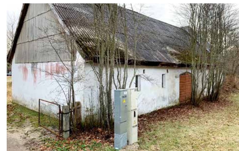
Vecās ēkas pagalma un ielas fasāde pirms pārbūves.
